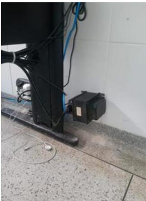
**Imagem 84** – Fixação de filtro de linha e transformador.
