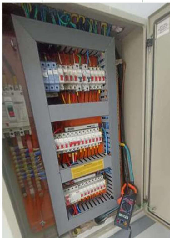
Manutenção preventiva de quadros elétricos
