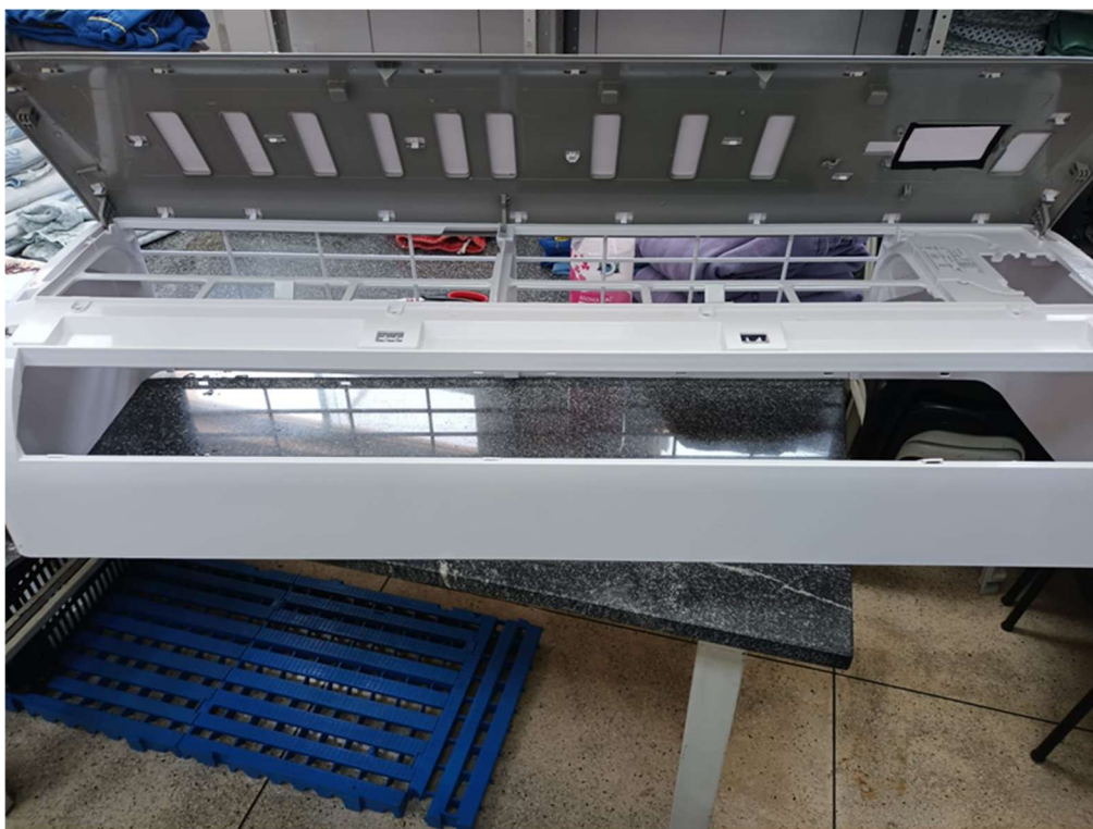
Manutenção preventiva em equipamentos de ar condicionado
